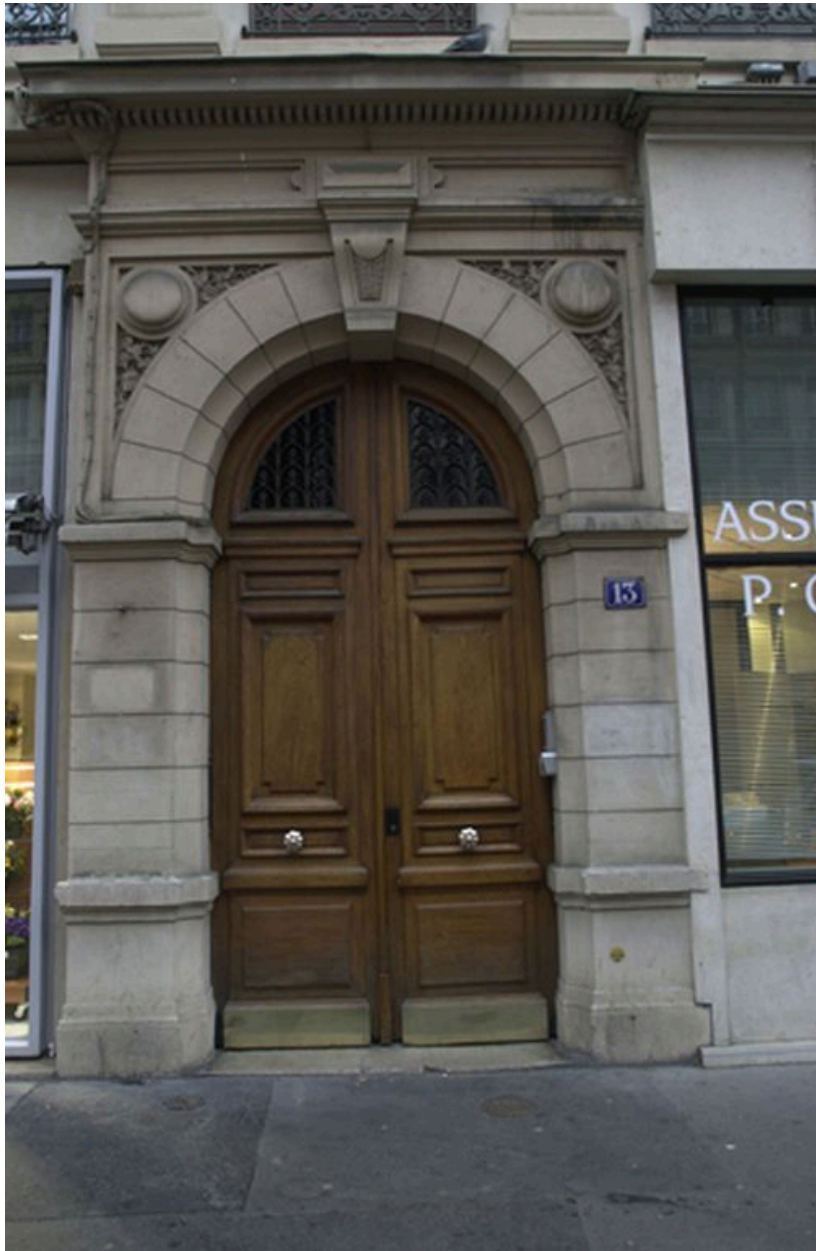
Vue générale de la porte d'entrée
