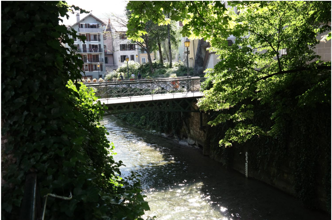
Passerelle de l'Évêché, vue de la face aval
