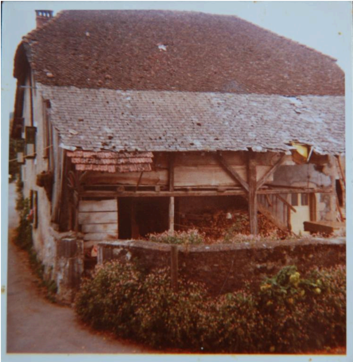
Ferme, puis maison (2016 A6 333, non repérée). Vue depuis le sud-est, avant réfection de la toiture (début des années 1980) (collection particulière).
