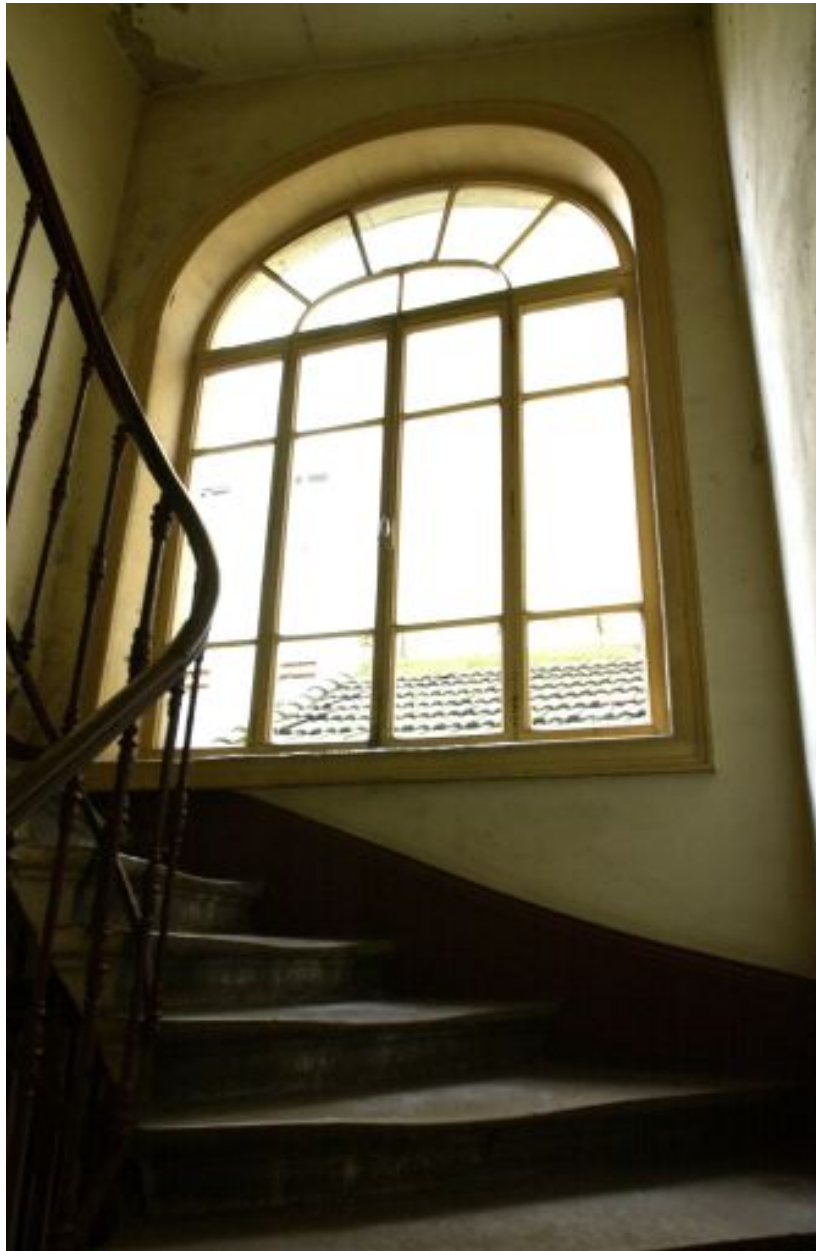
Détail de la fenêtre de la cage d'escalier, 9 cours Charlemagne
