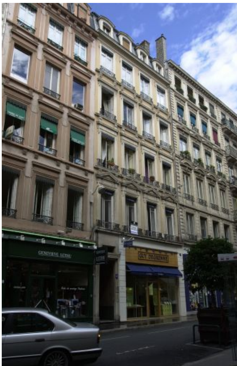
Façade, vue générale de trois quarts
