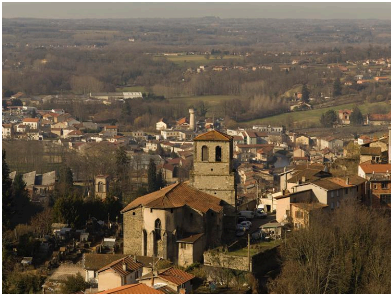
L'église dans le site.
