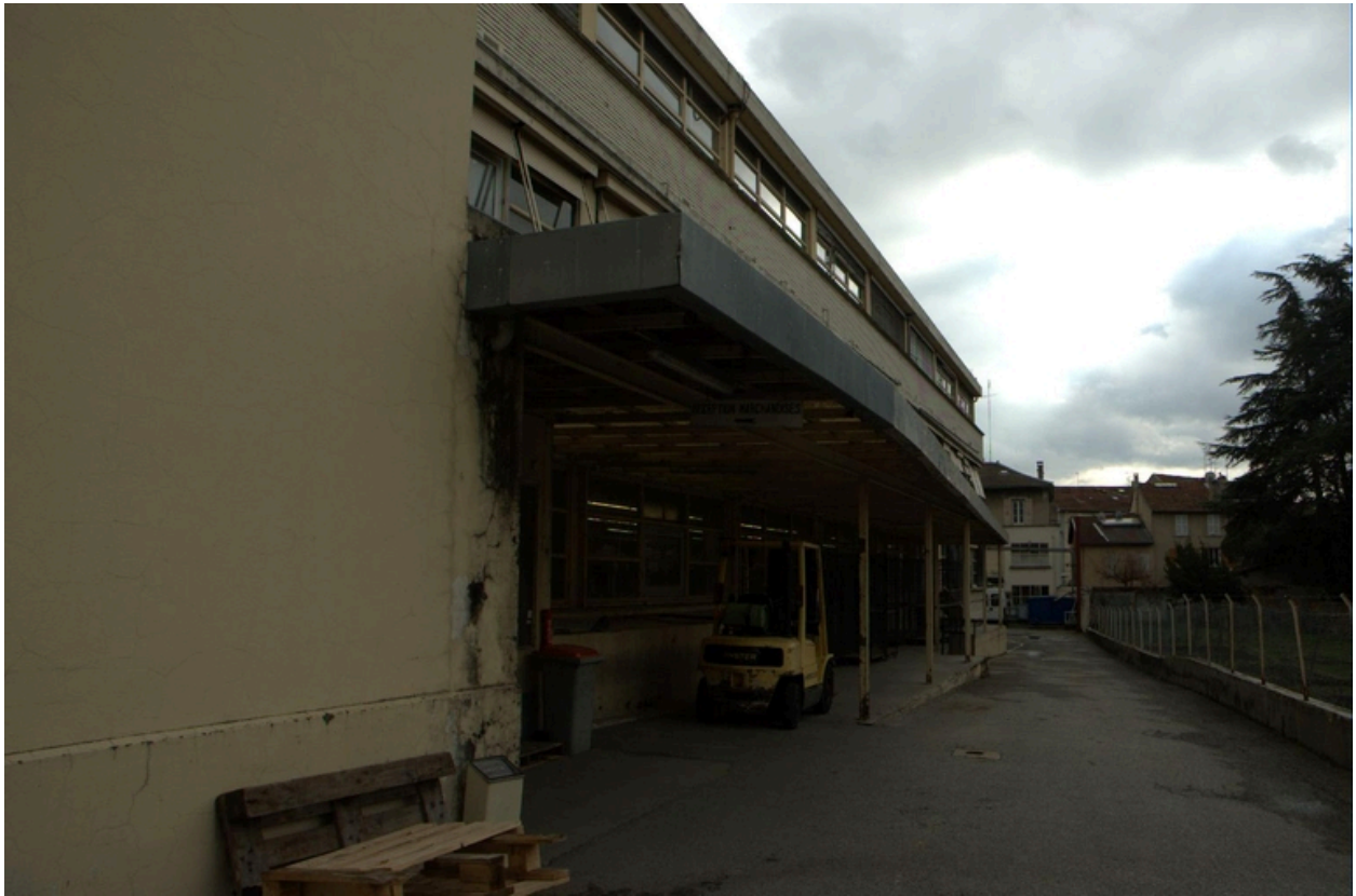
Quais de chargements
