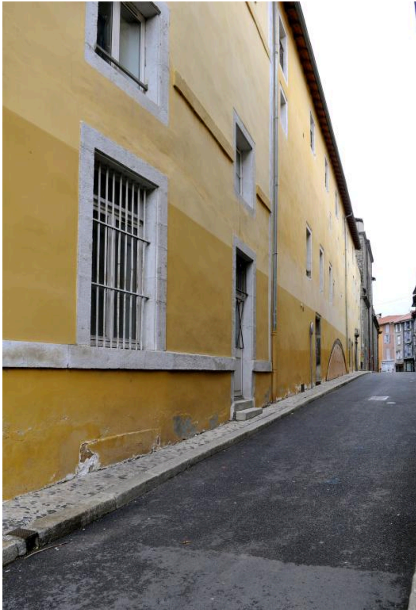
Bâtiment E, élévation sur rue depuis l'est
