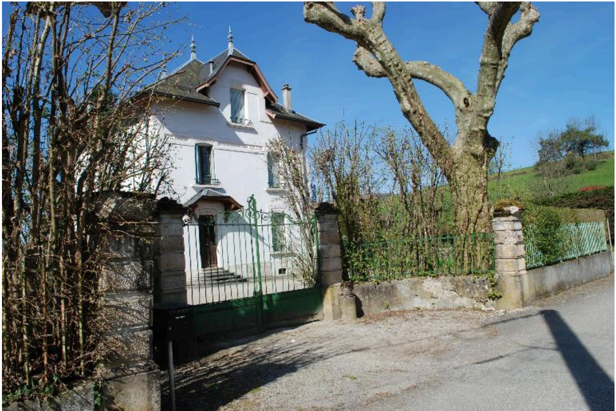
Vue d'ensemble de la façade est de la villa et du portail de la cour.
