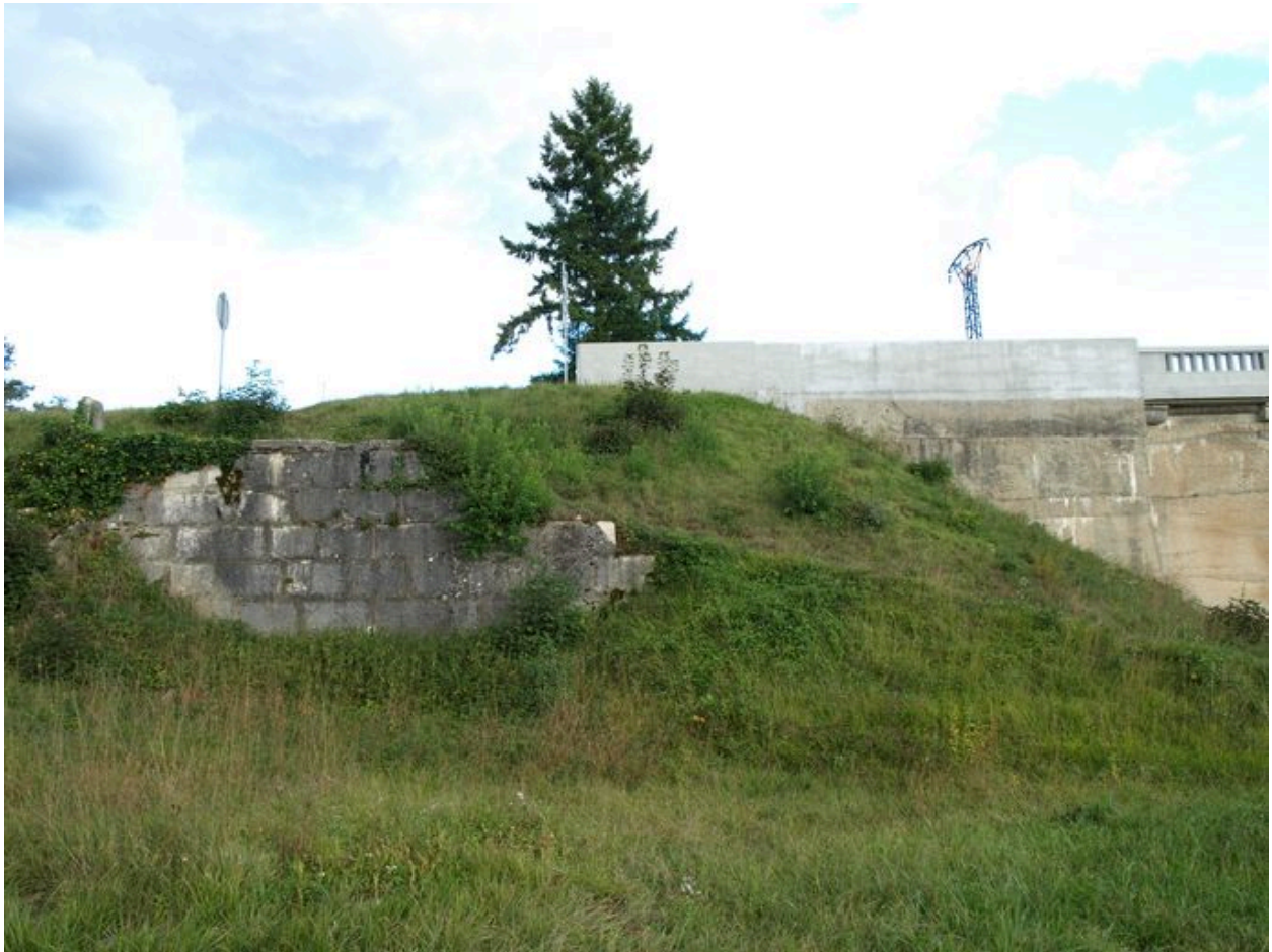
Vestiges de la culée droite, face aval, vue générale (depuis la rive droite) ; le pont actuel en arrière-plan
