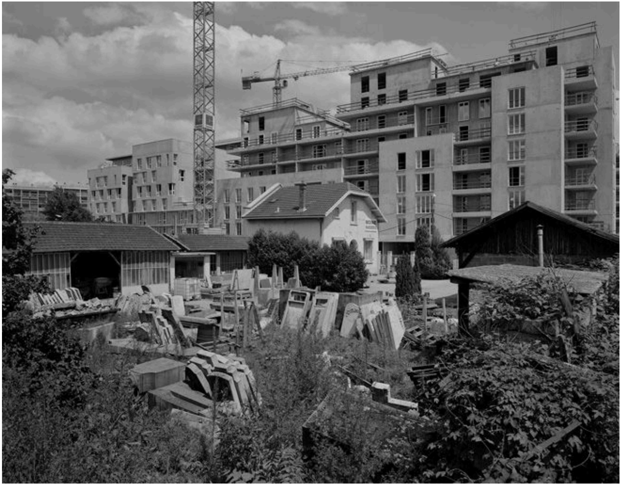
Vue générale depuis le sud-ouest
