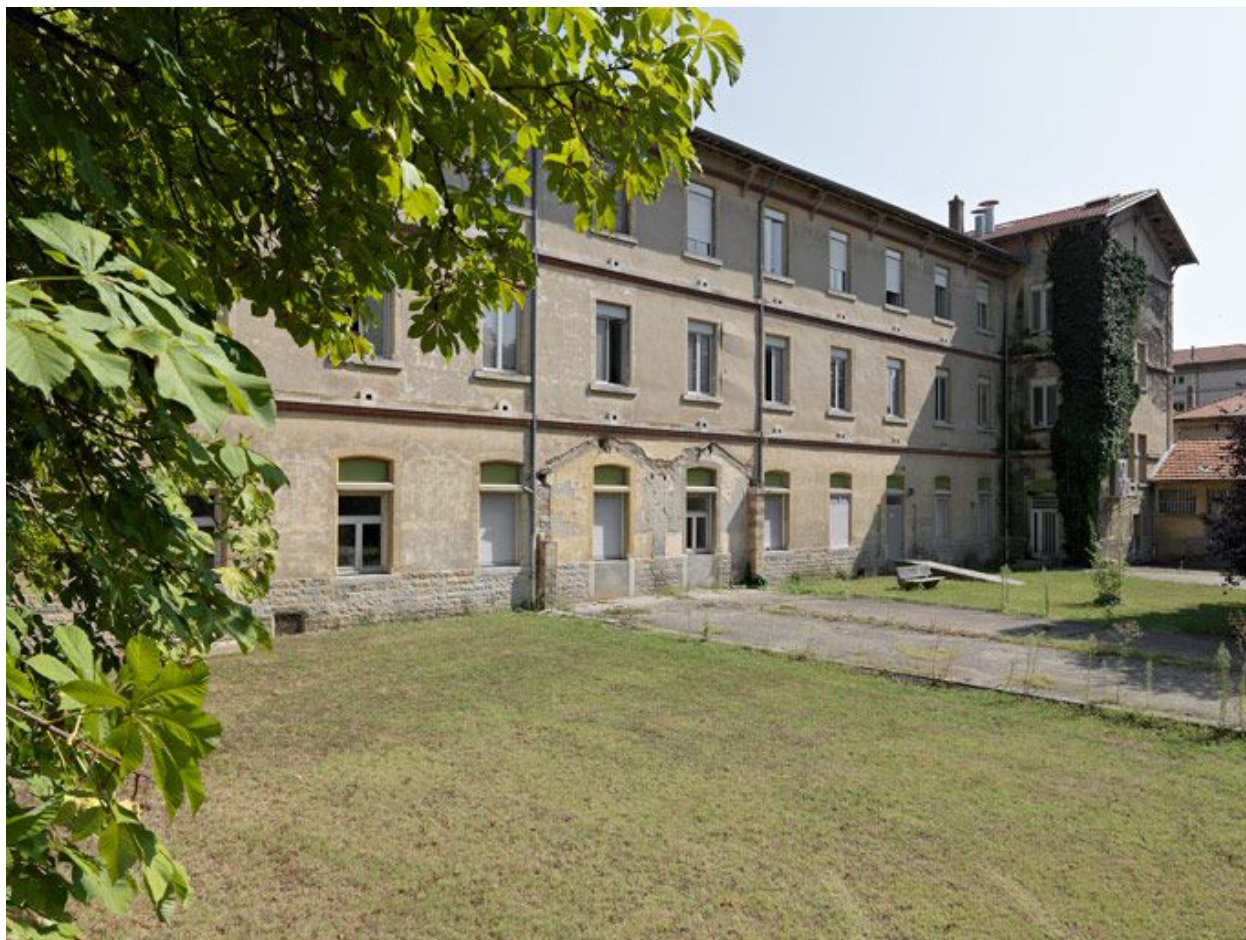
Façade postérieure (ouest)
