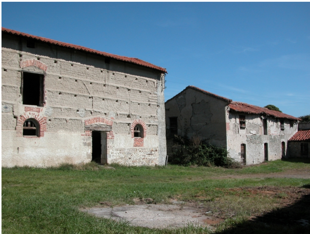
Vue du cellier et de l'étable nord.
