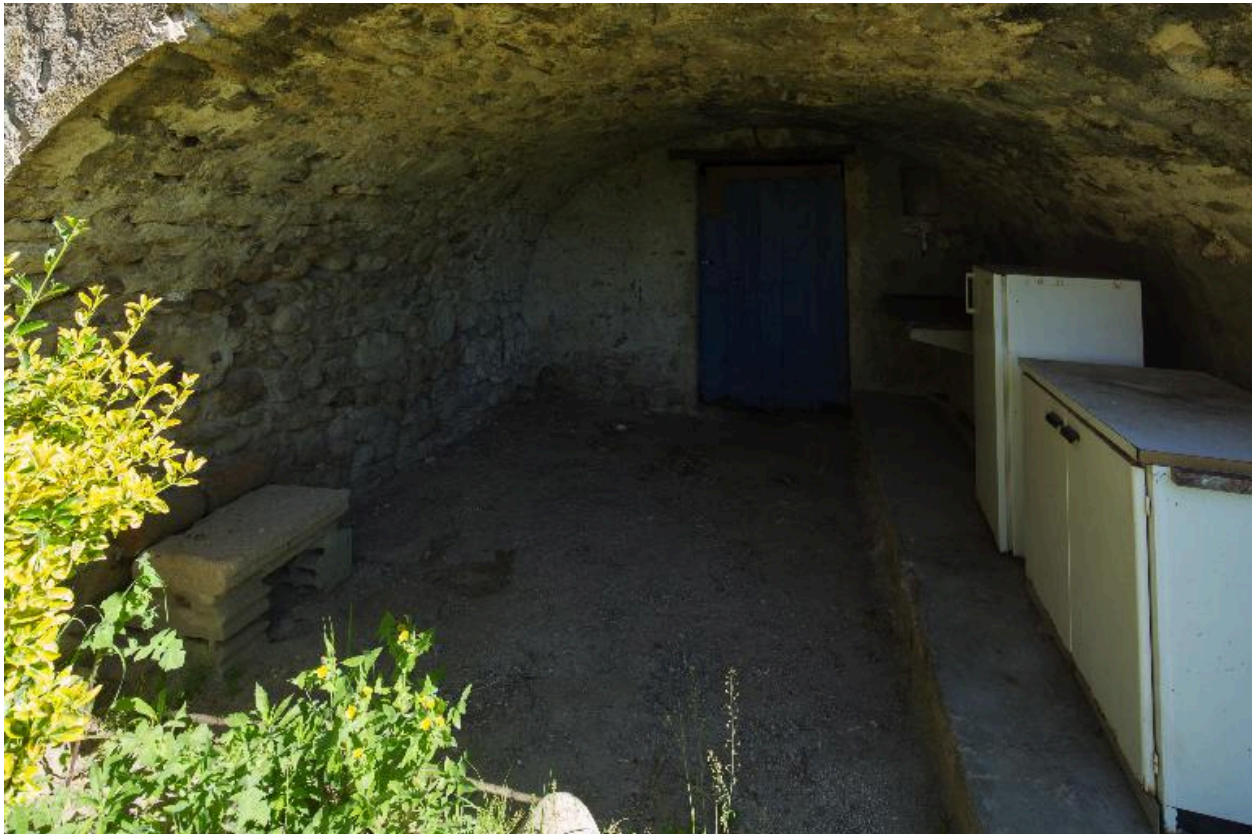
Maison : façade ouest, entrée de cave voûtée
