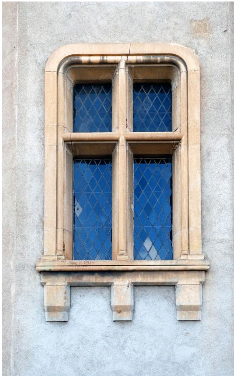
Tour d'escalier, détail d'une baie
