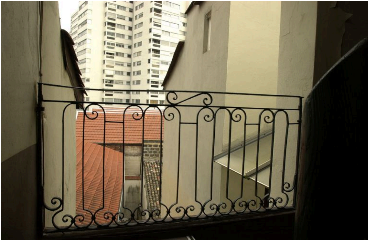
Le garde-corps du dernier repos de l'escalier
