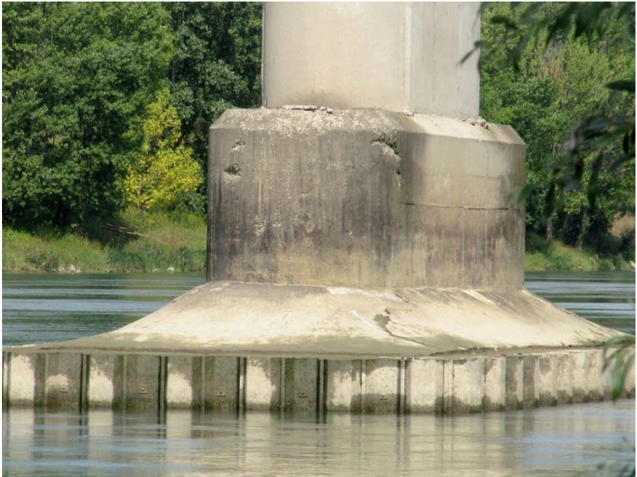
Soubassement d'une pile (depuis la rive gauche, face aval)
