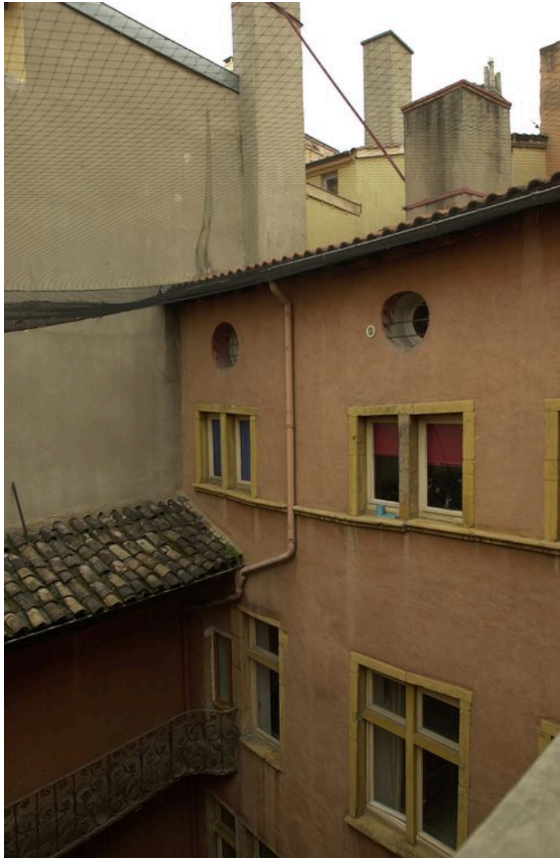
Elévation postérieure : derniers étages
