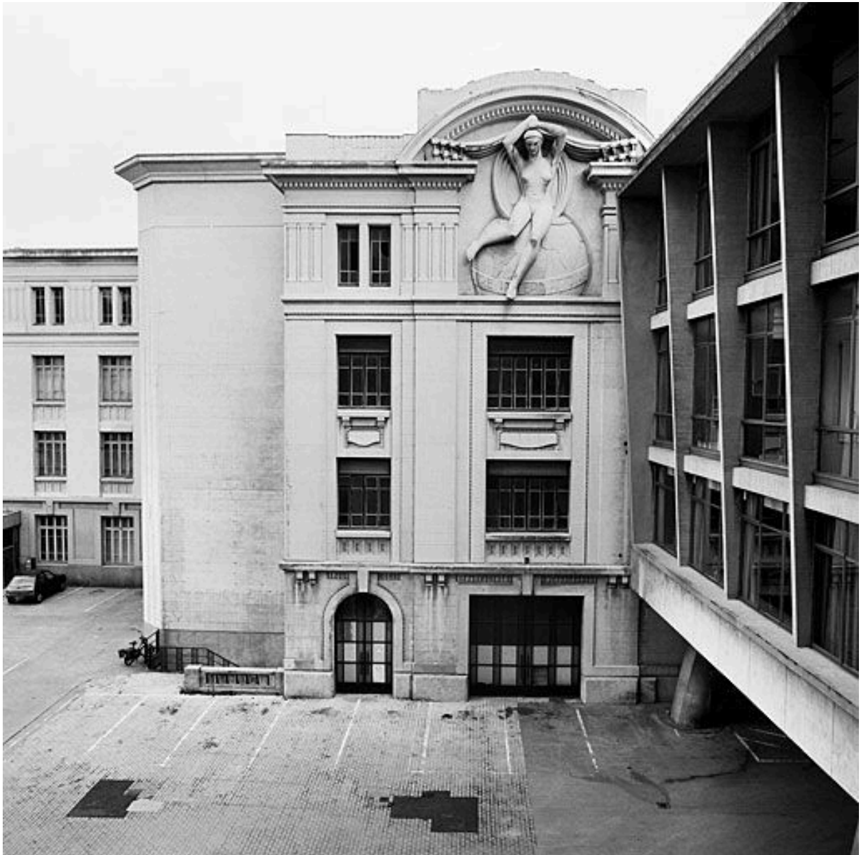
Vue partielle de l'élévation latérale gauche
