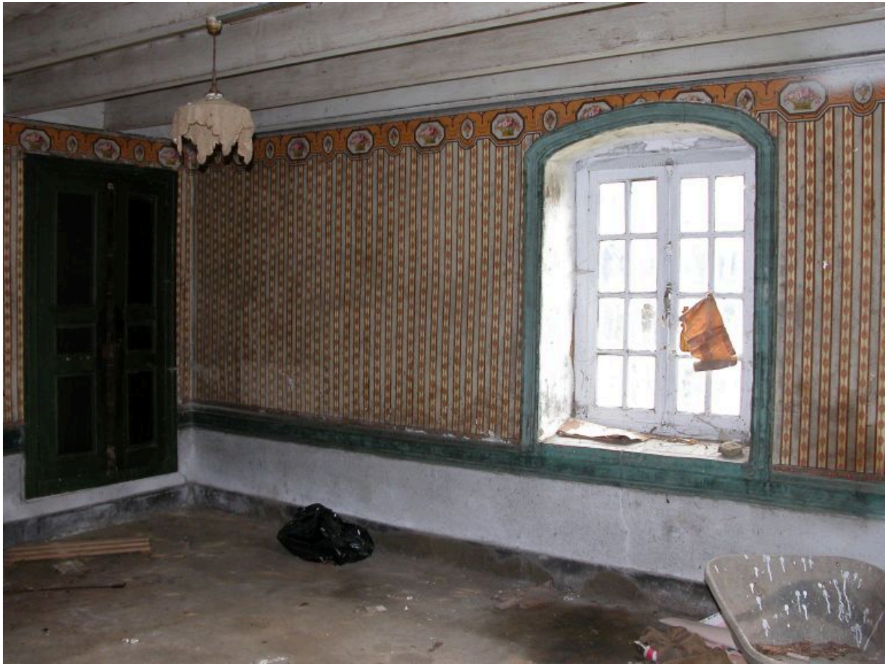
Logis nouveau, salle à manger. Vue d'ensemble du mur nord.
