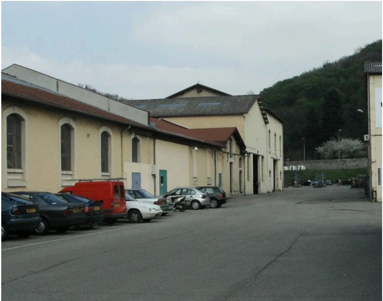
façade interieure de l'usine, vue ouest
