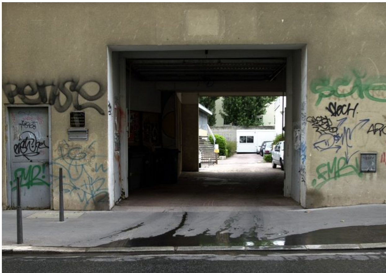
Vue du passage couvert depuis la rue
