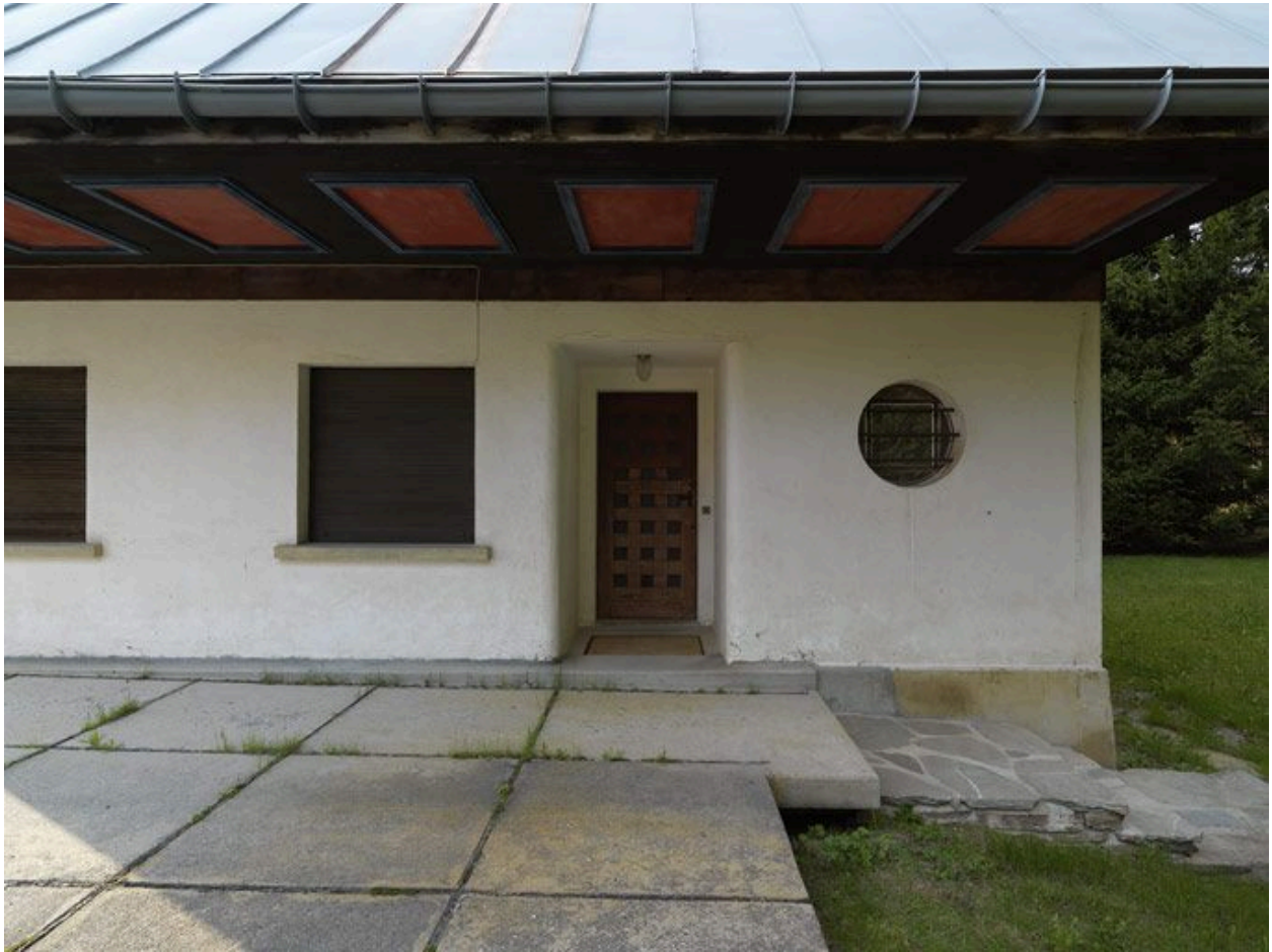
Entrée sud, ouvrant sur la terrasse, au niveau du rez-de-chaussée surélevé
