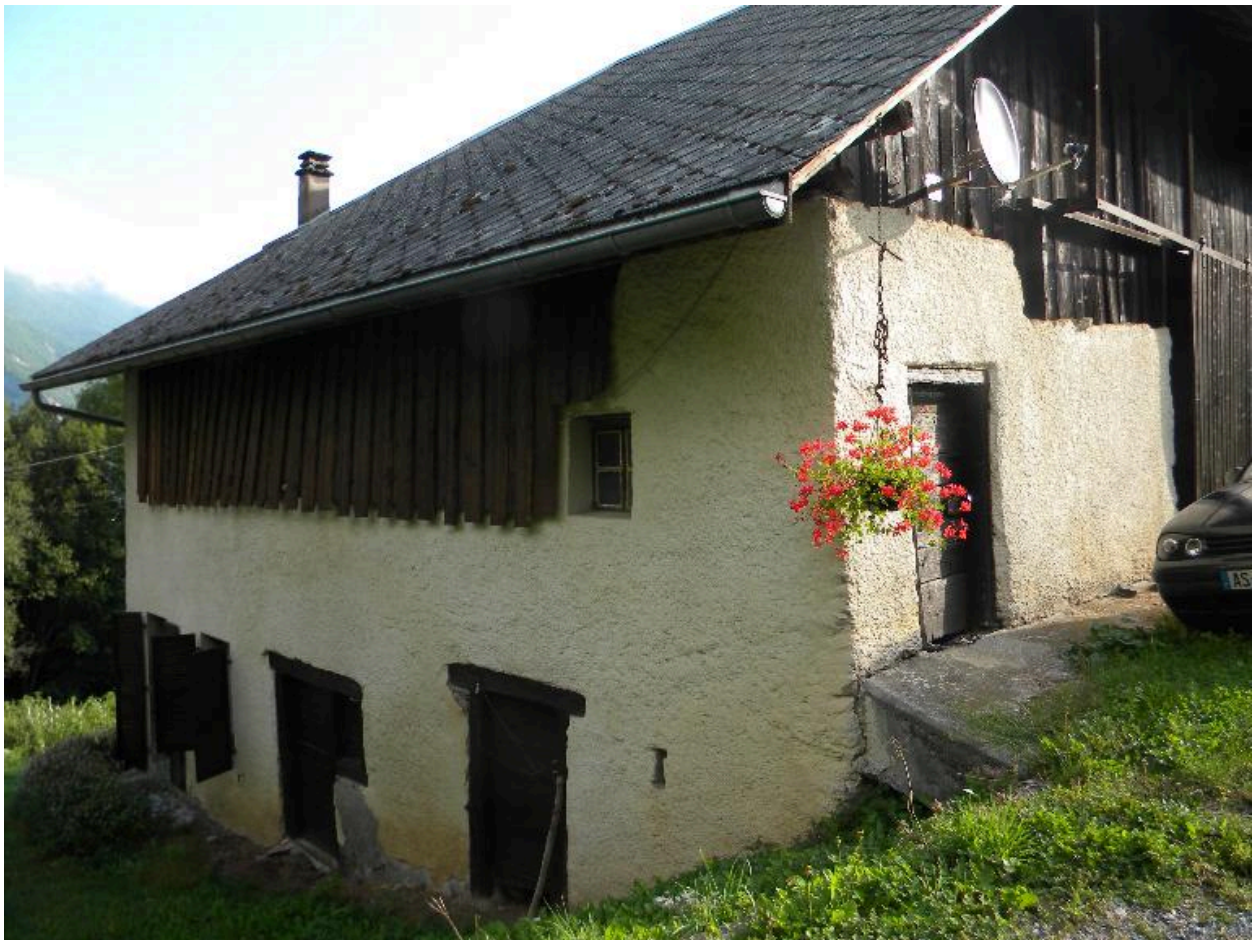
Vue de la façade nord-ouest.
