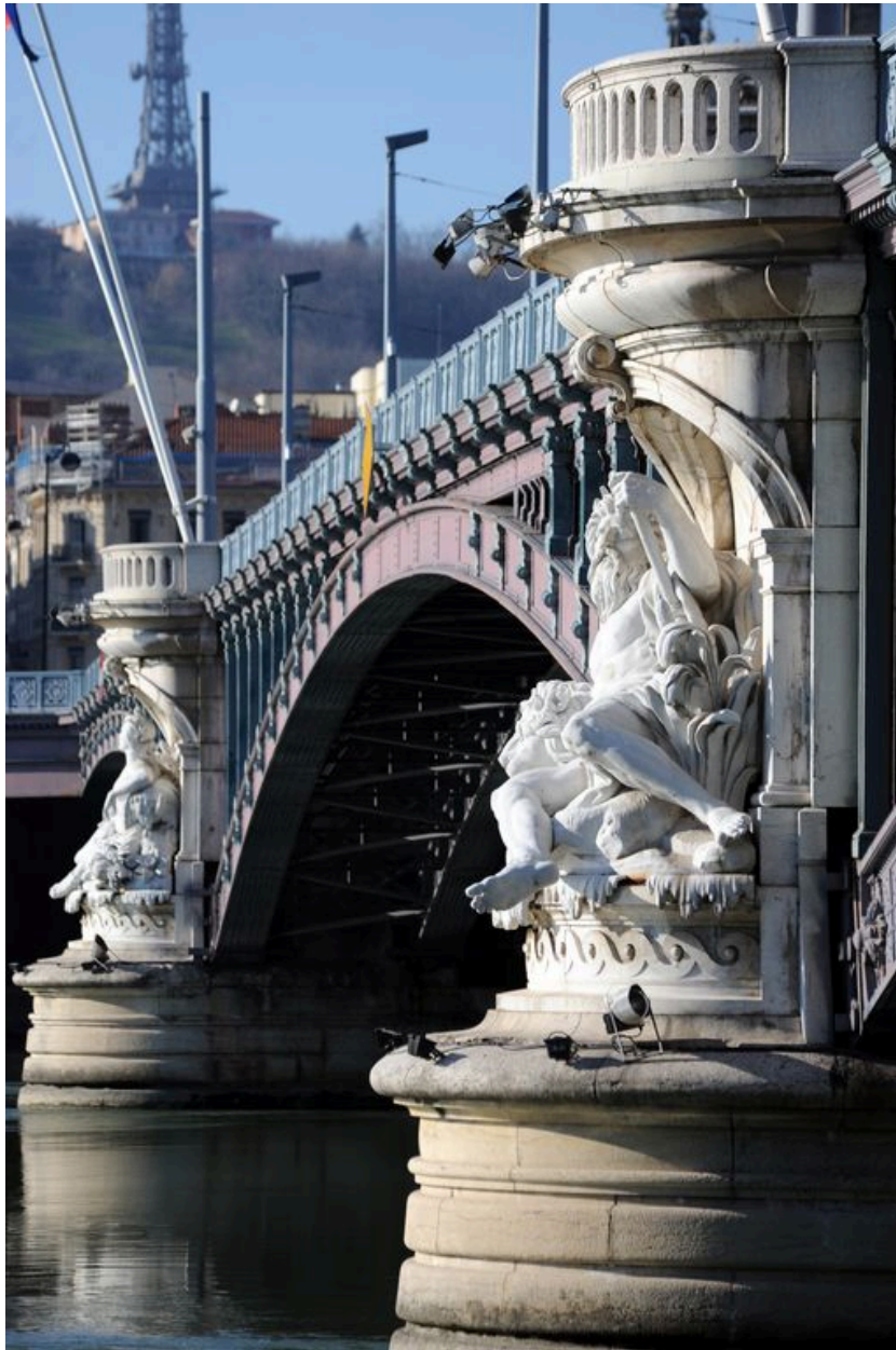
Vue latérale, piles et travée centrale, face amont (depuis la rive droite)
