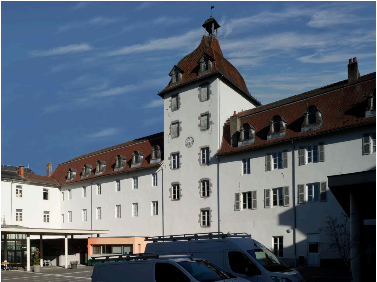
Bâtiment C : élévation sur cour, vue d'ensemble depuis le nord-est
