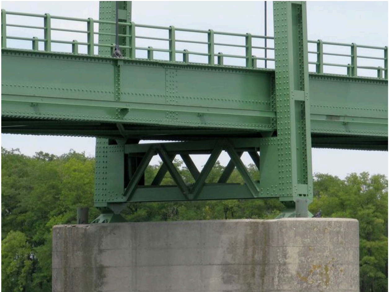
Détail de la pile et du pylône central, face aval (depuis la rive droite)
