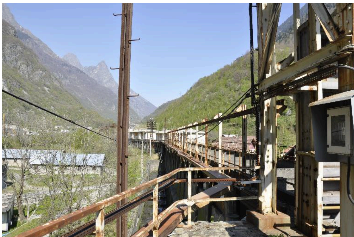
Vue du canal
