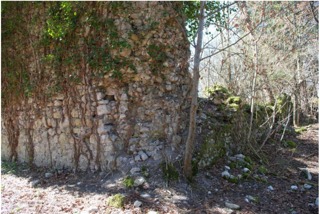
Château, élévation extérieure de l'angle nord-est et nord des murs.
