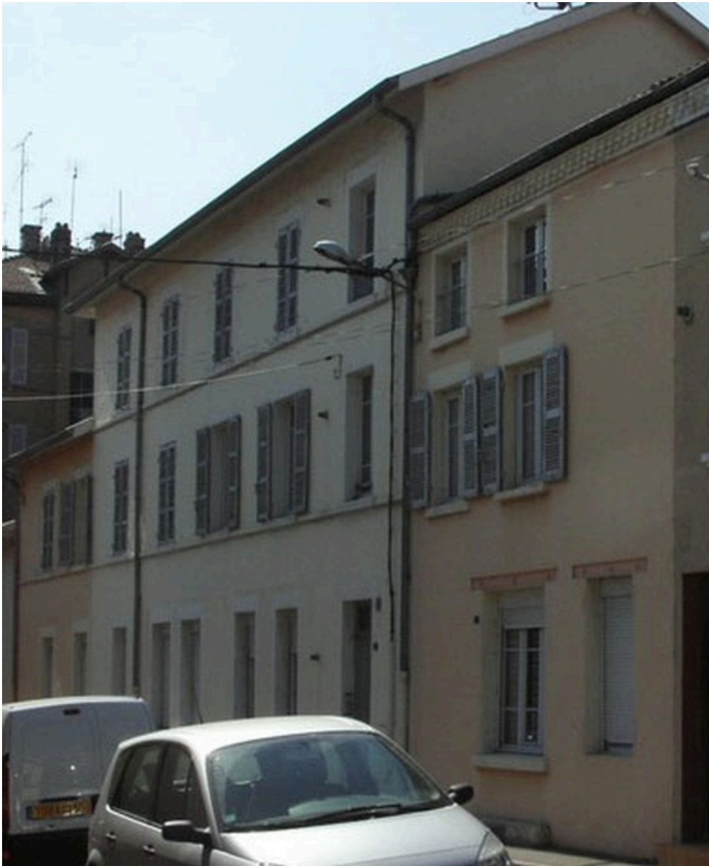
façade sud est
