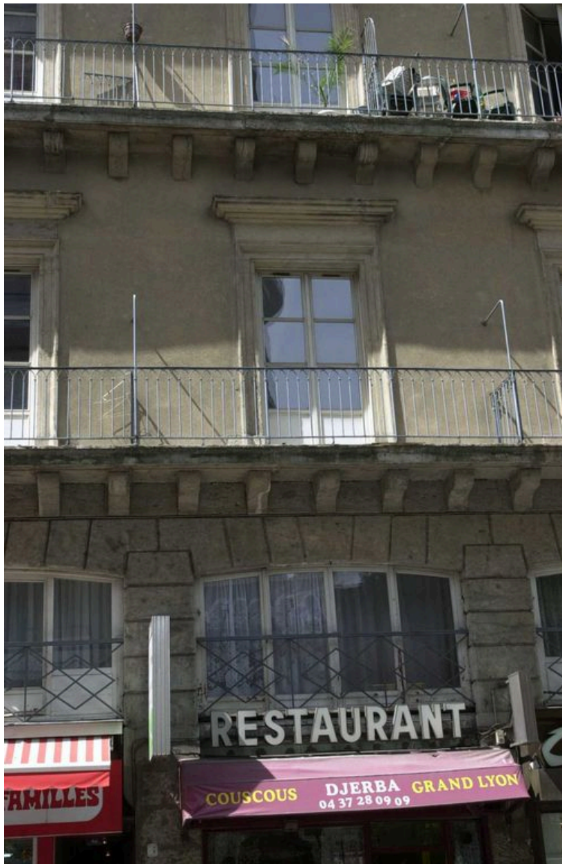
Vue de l'entresol et du balcon du 1er étage
