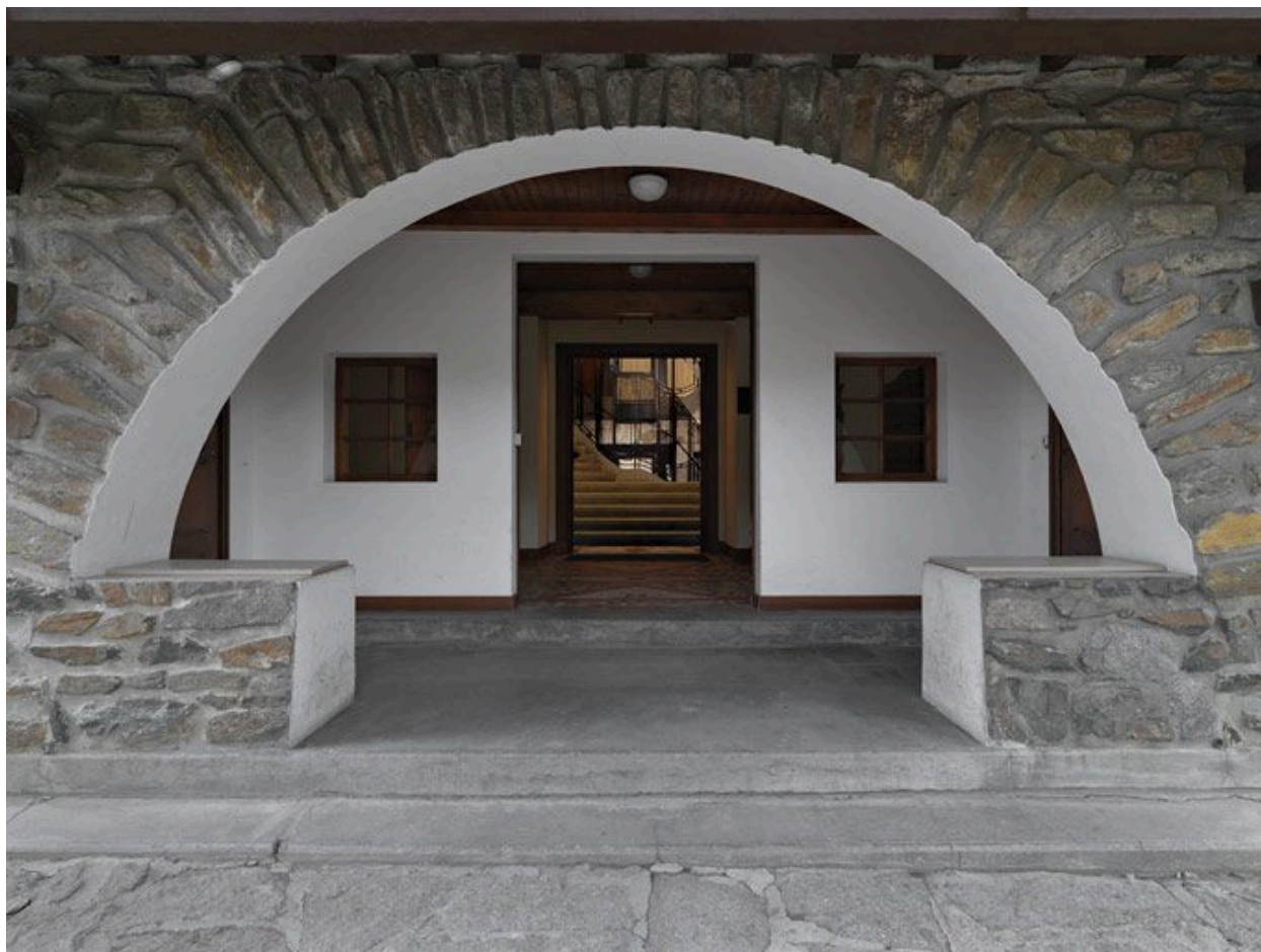
Entrée de l'immeuble
