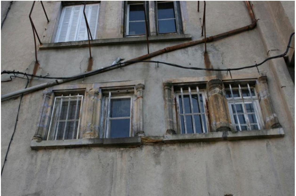
Fenêtres du 1er étage de soubassement, sur l'élévation principale d'origine, au sud-ouest, côté rue des Sapeurs-Pompiers (photographie chercheur).
