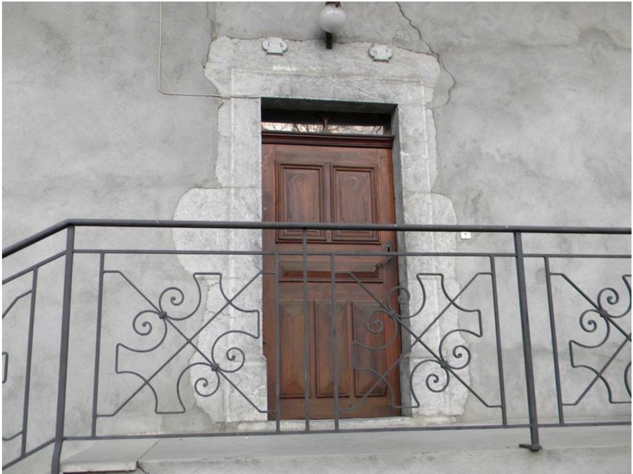
Porte d'entrée derrière le garde-corps en fer forgé.
