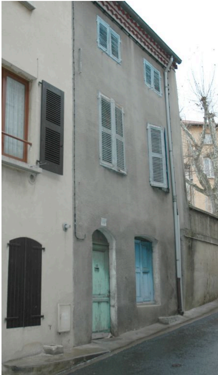
Vue de l'élévation principale sur rue, avant restauration.
