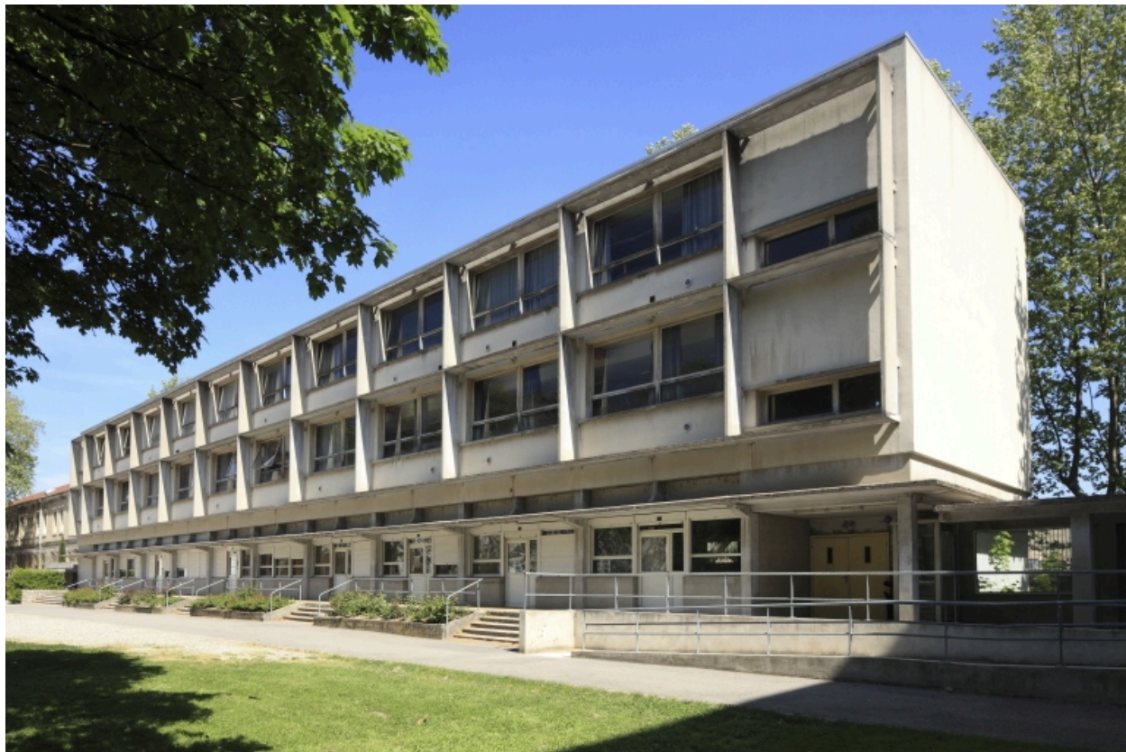
Bâtiment D : les salles de cours.
