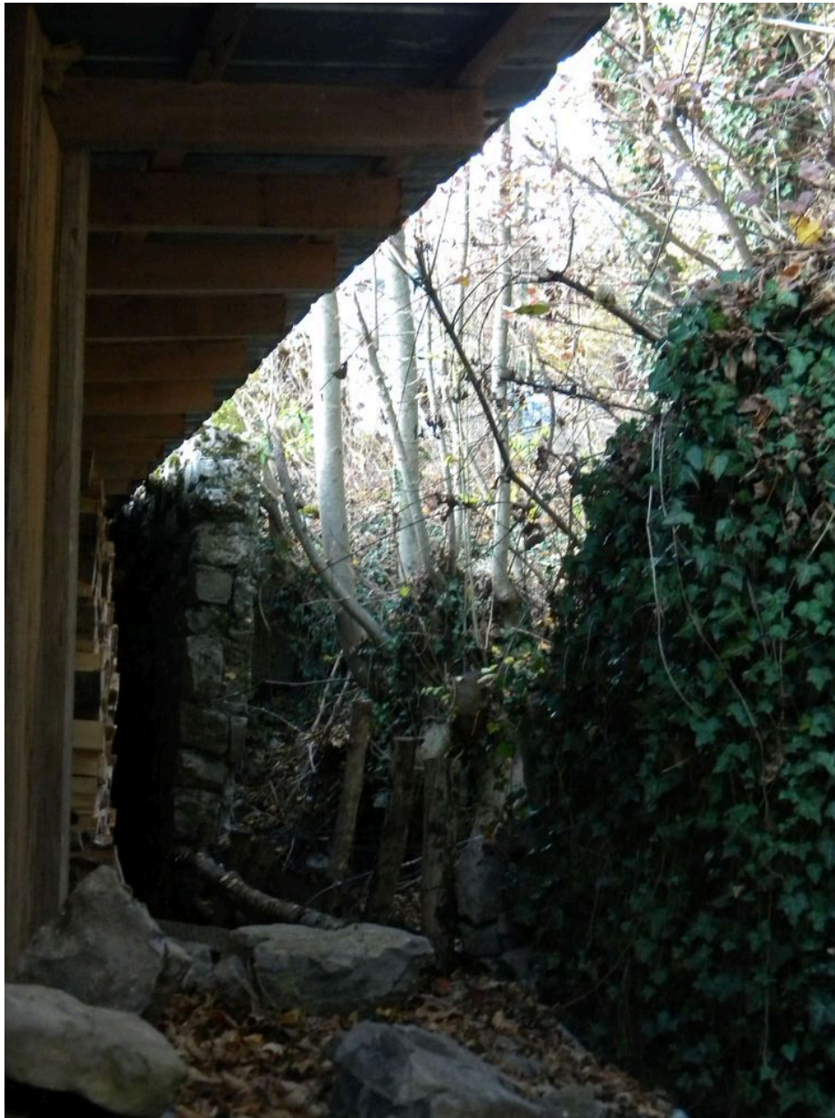
Vue des vestiges de bâtiments derrière un abri à bois. (2008 A8 2705)
