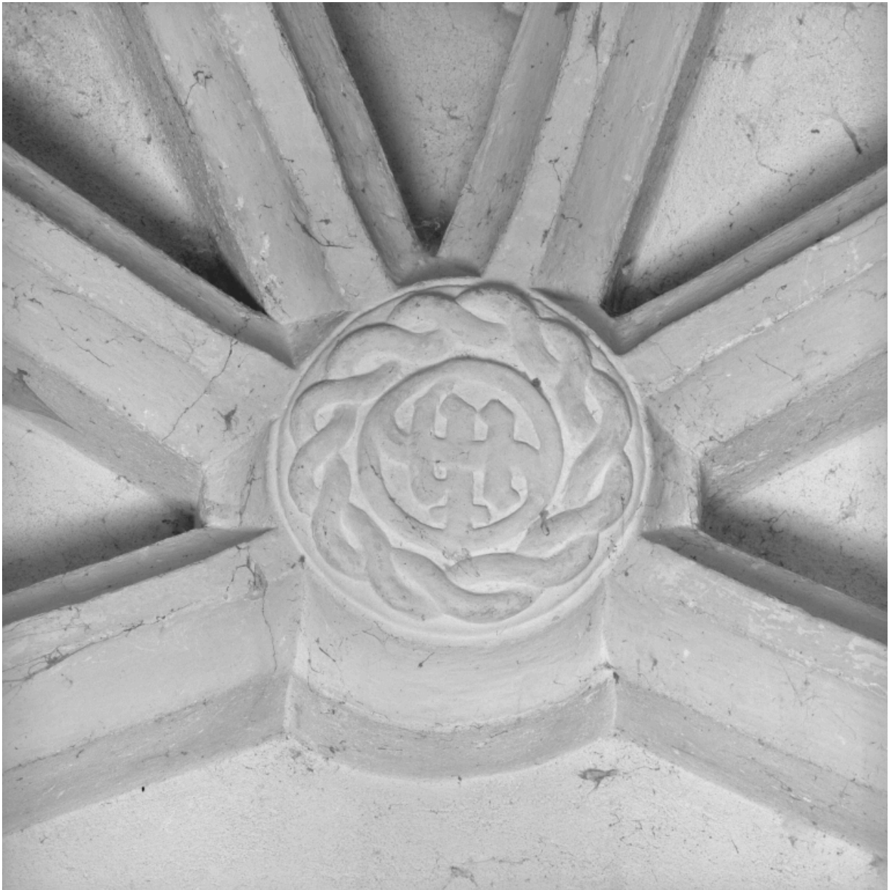
Détail de la clef de voûte de l'abside.
