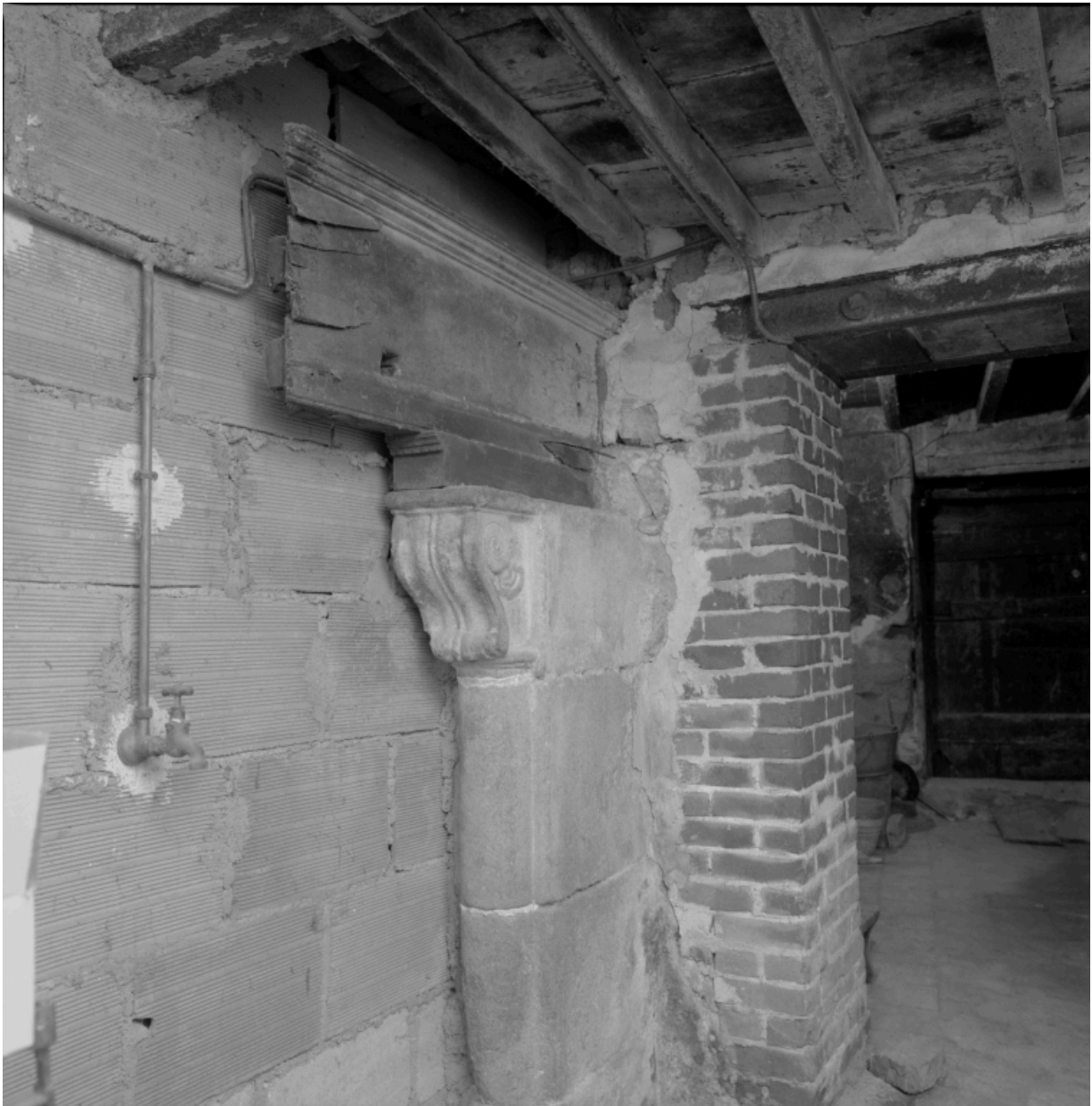
Vue de la partie haute du piédroit et du linteau en bois d'une cheminée située dans une ferme à Mallard, commune de Boën (1986 AH 195, 196).
