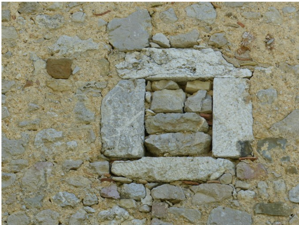
Partie ouest. Elévation ouest, deuxième niveau. Fenêtre.
