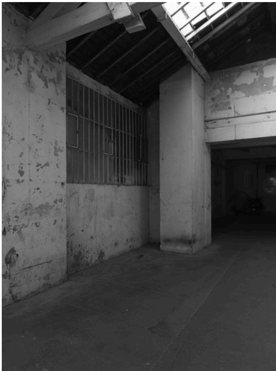
Détail des espaces et éclairage zénithal du rez-de-chaussée
