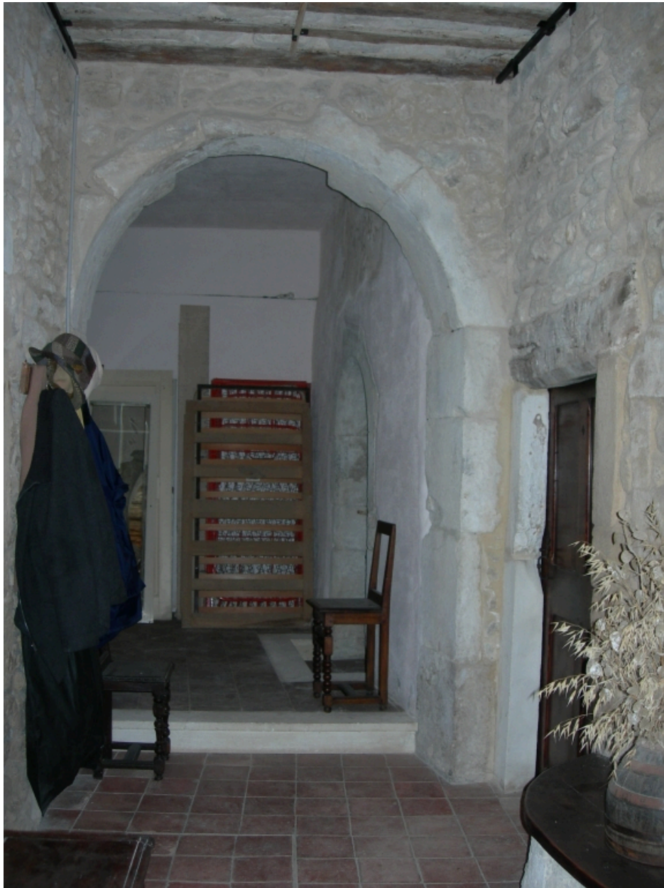
Rez-de-chaussée, dégagement à gauche de l'escalier en vis.
