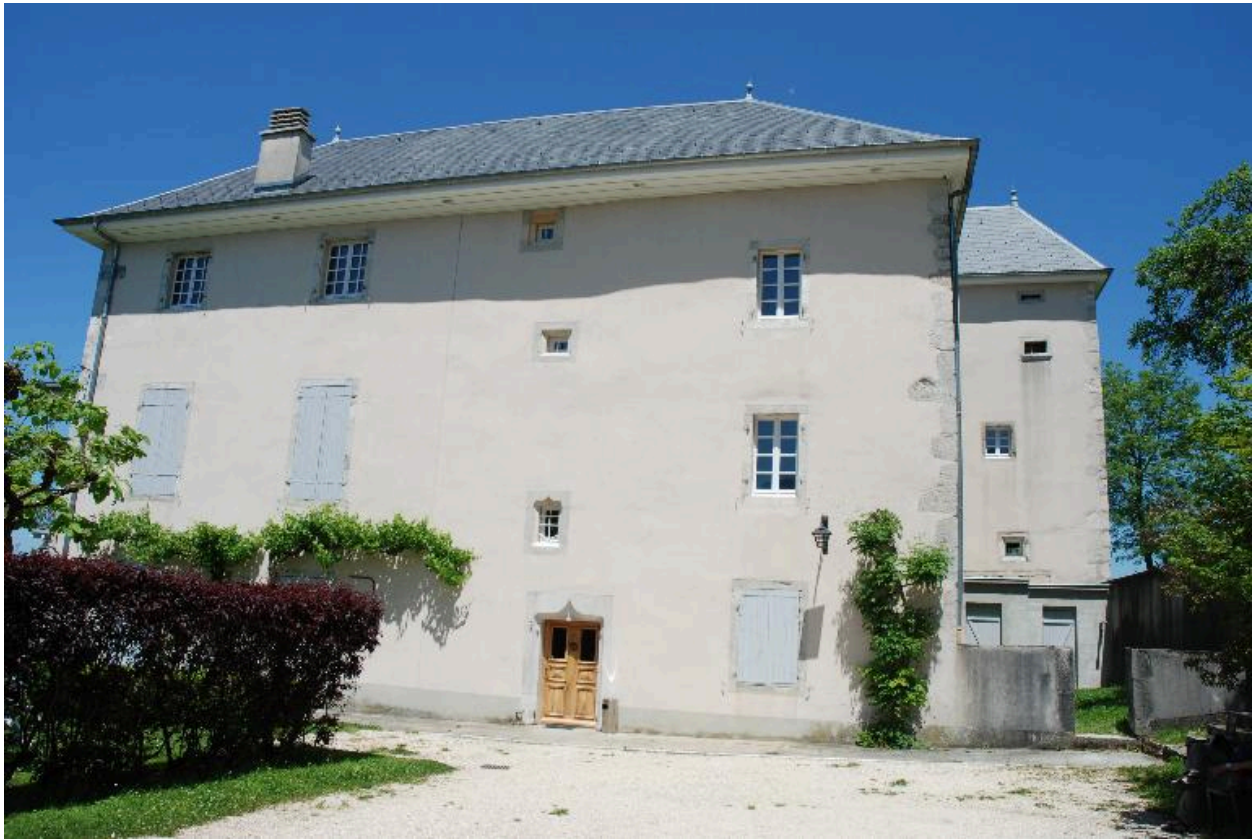
Vue d'ensemble de la façade sur cour.
