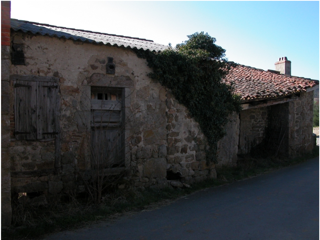
Vue du logis nord et de la grange, depuis le nord-est.
