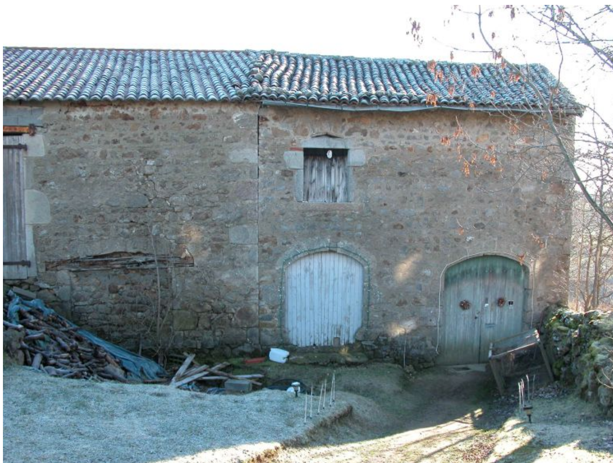
Vue d'ensemble arrière du portail d'entrée de la cour fermée.
