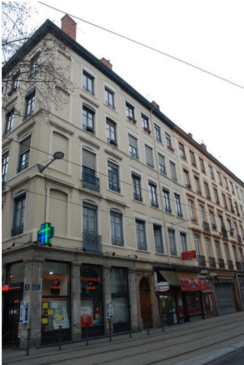
Elévation ouest, donnant sur la rue de Marseille
