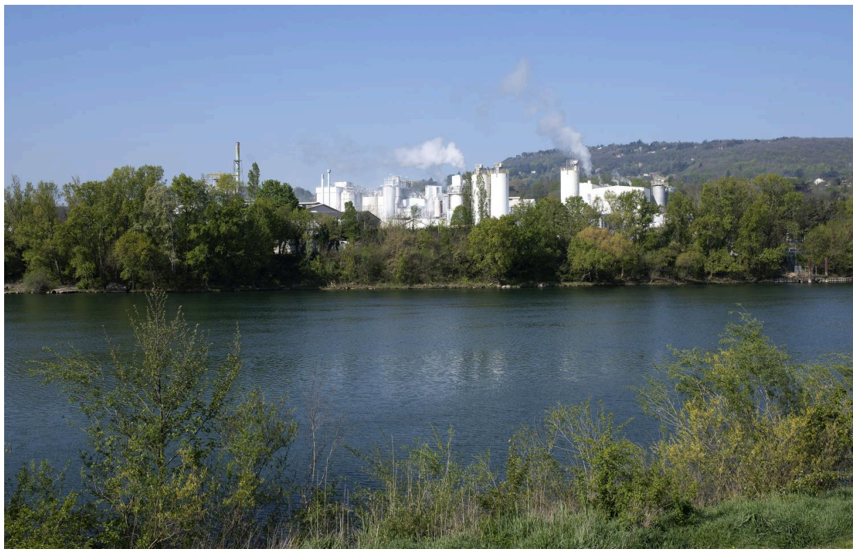
Vue d'ensemble est côté Saône
