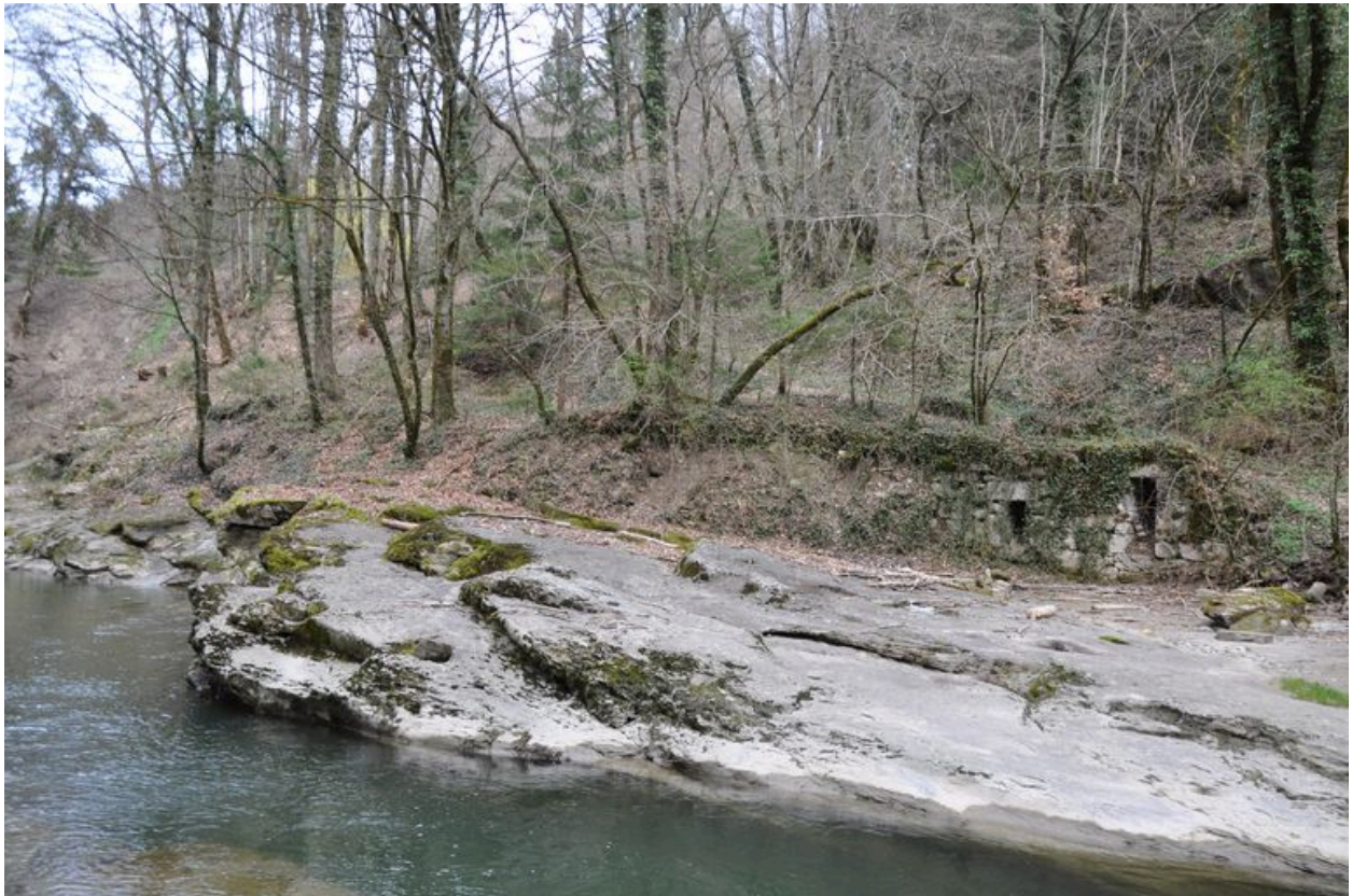
Vue générale des massifs de la scierie
