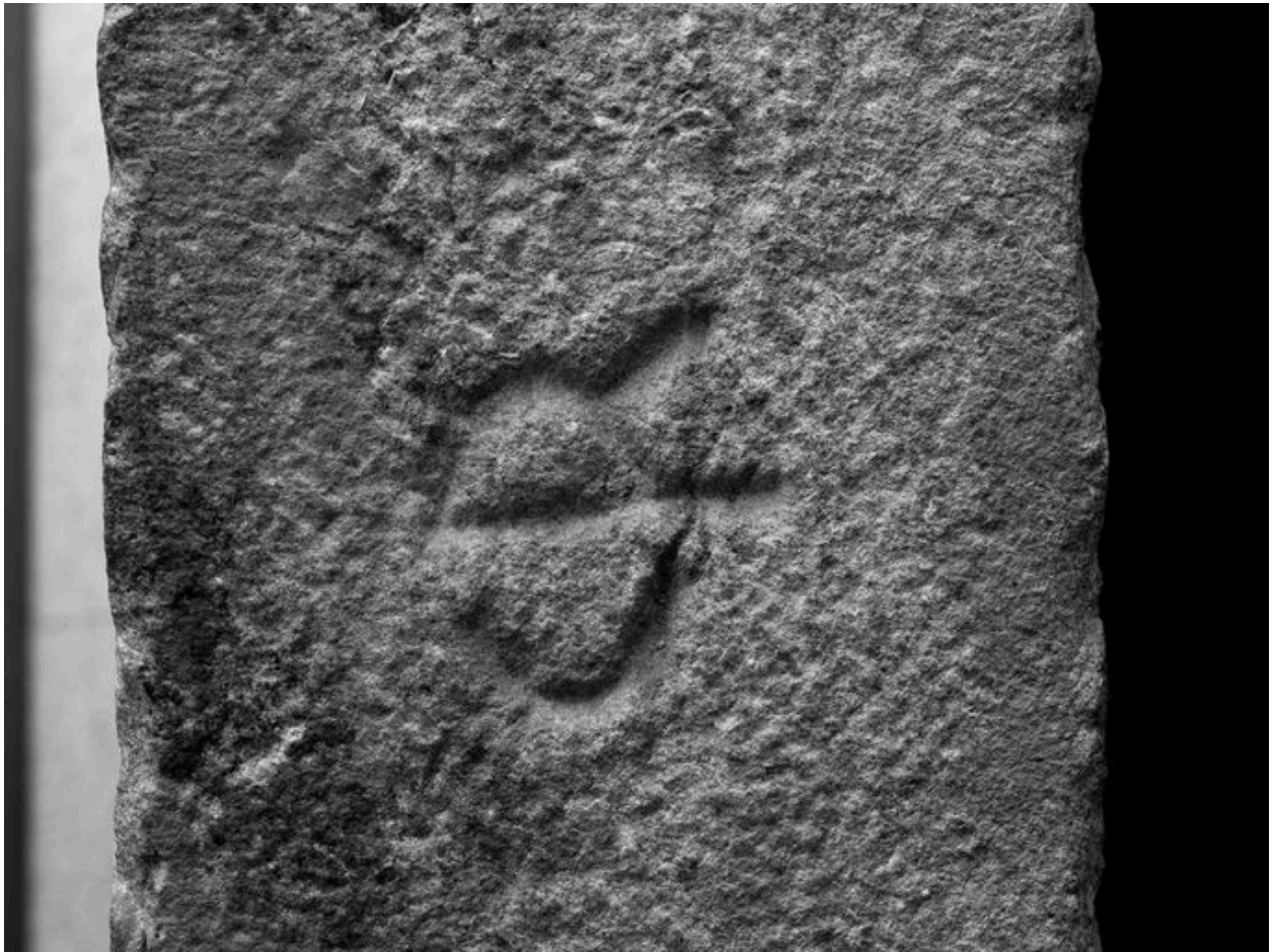
Détail de la marque de tâcheron CR gravée sur les piliers de l'escalier et sur des encadrements de porte
