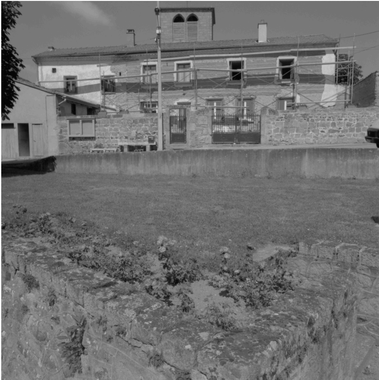
Vue de l'élévation antérieure du presbytère en travaux : pisé apparent.
